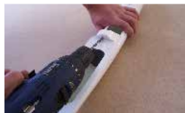
86. ...vyvrtáme otvor Ø6mm ( je vhodné si jej nejdříve předvrtat vrtákem menšího Ø) ... drill hole ø 6 mm (we recommend drill smaller hole first).
